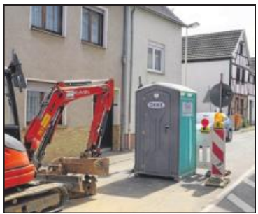
Das Toilettenhäuschen auf der Domhofstraße. FOTO: AXEL VOGEL
