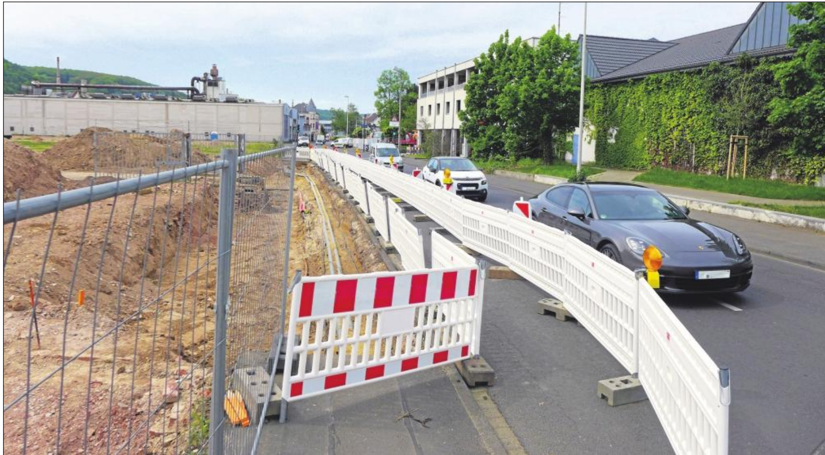
Am Grundstück Friesdorfer Straße haben die Arbeiten begonnen. Wegen des Kreuzungsumbaus wird es für Autos enger. FOTO: RICHARD BONGARTZ
